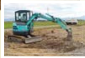
田んぼの作業効率を高める区画拡大のために行う「畔抜き」
