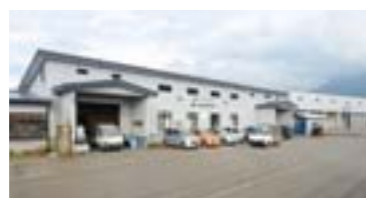
第一バックセンター外観
