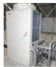
八海山の伏流水を活用して熱源に。地下水利用ヒートポンプ
