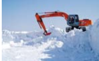
重機による圃場の除雪作業
